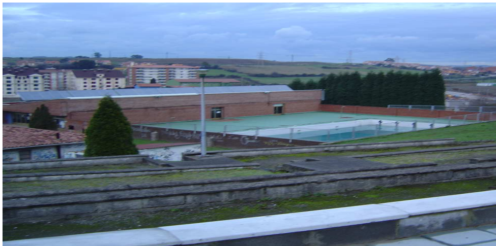
Propuesta de IU; Con la piscina de la imagen climatizada
